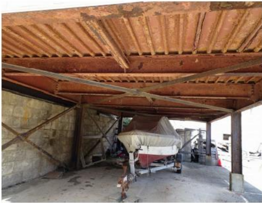
物件 5 屋根材裏側
