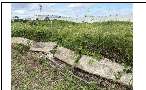
5 西境界、擁壁の状況
