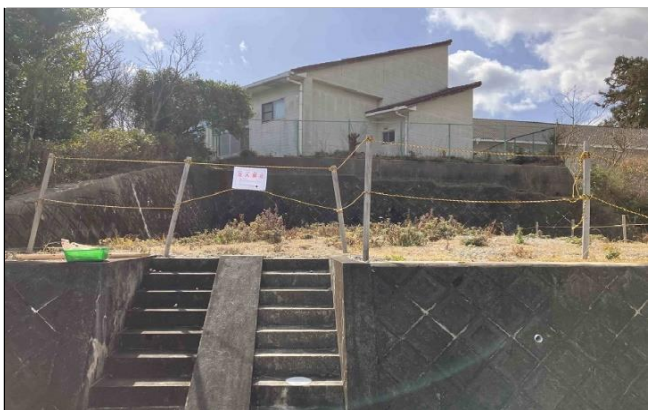
1 道路から物件を望む
