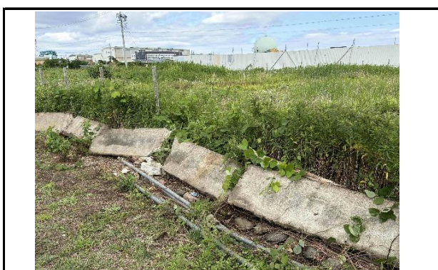
5 西境界、擁壁の状況
